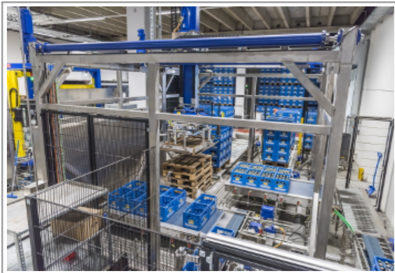
Palettiert werden die fertigen Versandverpackungen von einem kombinierten Be- und Entlader. Dieser Portalpalettierer übernimmt zudem das Palettenhandling.
